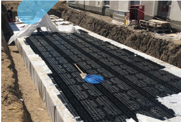
Vorher: Einbau von Kunststoff-Füllkörperrigolen unter Hof
