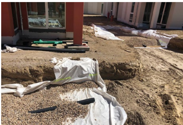
Vorher: Errichtung einer intensiven Begrünung auf Tiefgaragendach
