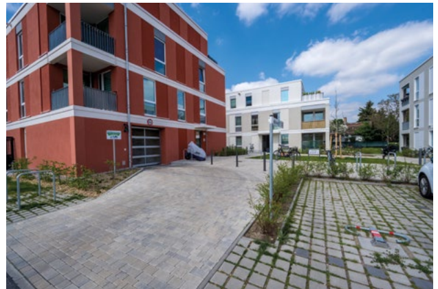
Nachher: fertiggestellter Hof mit nicht ersichtlicher unterirdischer Rigole
