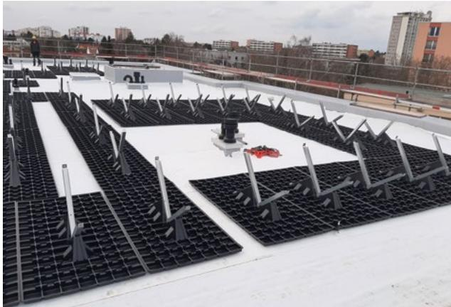
Im Bau: Retentionsdach mit Photovoltaikanlage. Hier im Bild ist die Aufständering für die Module zu sehen.
