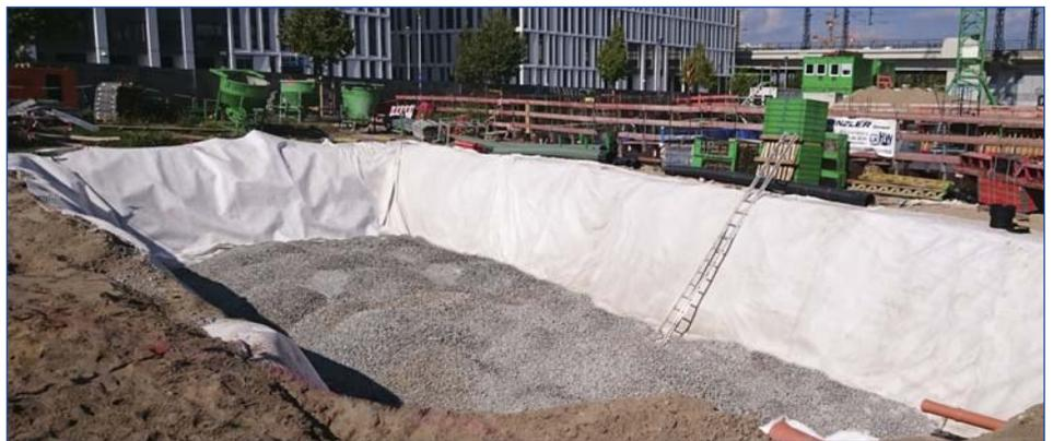
Verlegung der Bentonitbahn auf dem Scheitel der Versickerungsebene bzw. der Sohle der Vorhaltung des GEO PROTECT®-Kombisystems.
