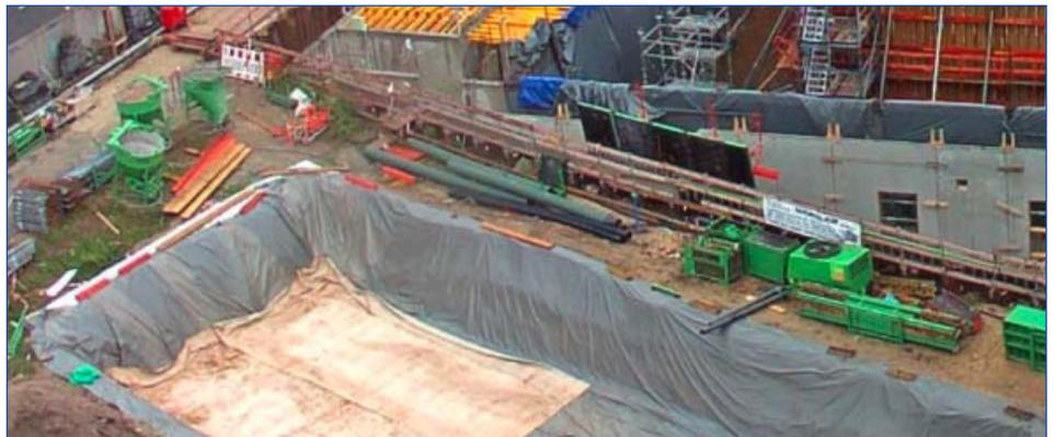
Einbau und lagenweises verdichten des Speicherminerals kurz vor Erreichen des Scheitels des GEO PROTECT®-Speichers.
