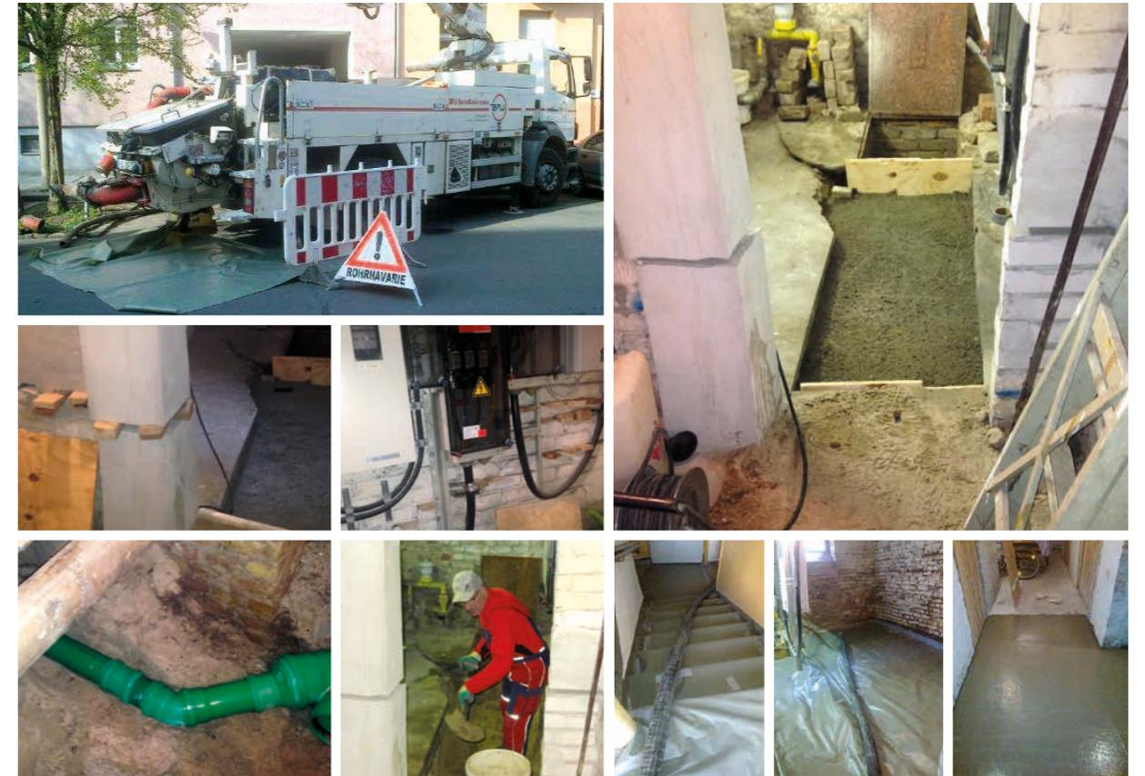
„Schadensbehebung und Wiederherstellung des Entwässerungskanals wurden dann umgehend in Angriff genommen. Zuvor hatte man sorgfältig zwischen offenem und geschlossenem Verfahren abgewägt. Zur Sanierung rückte TBS Rinne mit be-
