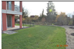
Versickerungsmulde an der Ortolofstraße Berlin (Foto: Sieker)
