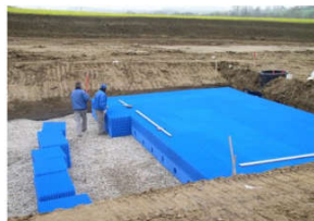
Bau einer Füllkörperrigole (Foto: Sieker)
