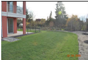
Versickerungsmulde an der Ortloffstraße Berlin (Foto: Sieker)
