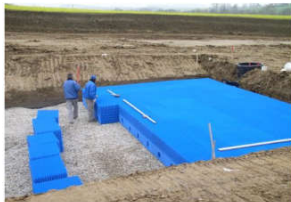
Bau einer Füllkörperrigole (Foto: Sieker)
