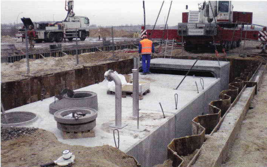
Der Löschwasserspeicher wird in die Grube gelassen. | Foto: Mall
