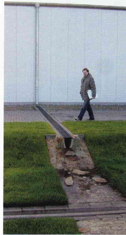
Die Sickermulde für Dachwasser entlang der neu gebauten Produktionshalle.
