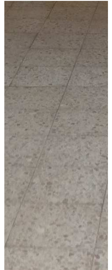
Betonplatten im Bestand
