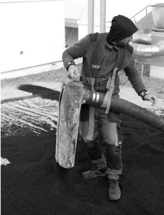
Das Pflanzsubstrat wurde in Silofahrzeugen angeliefert. Von dort wurde das Substrat mit Druckluft über Schläuche auf das Dach geblasen und dort ausgebracht. (Foto: IBeB)
