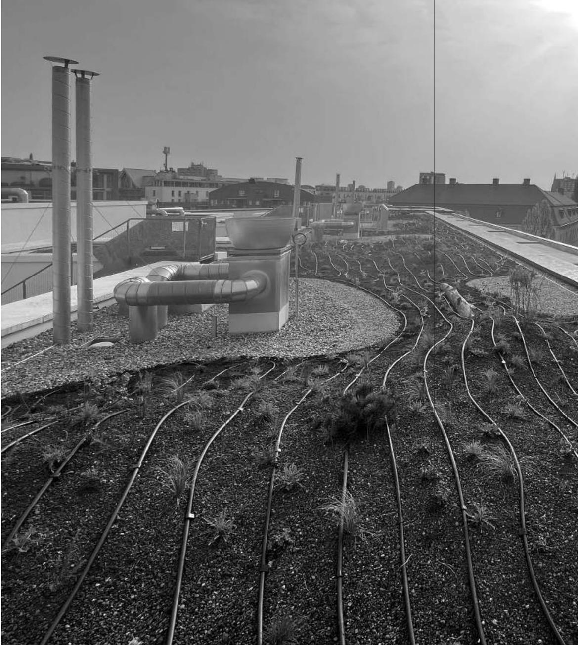
Die **Bewässerung** der Pflanzen erfolgt hauptsächlich im Sommer bei Bedarf. Die Intensität der Bewässerung kann auch über ein Smartphone gesteuert werden.
