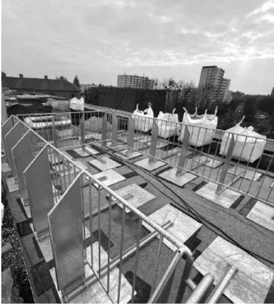
Ein großer Teil der Geländerkonstruktion ist nicht sichtbar: Stahlplatten und -profile werden durch das Pflanzensubstrat und die Betonplatten beschwert; eine Befestigung an der Gebäudedecke ist nicht erforderlich.
