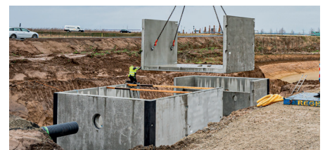
Bis zu 37 Tonnen wiegt ein einzelnes Betonelement.
