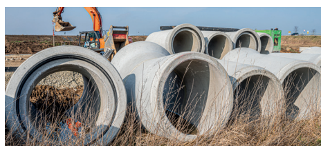
Bis zu 37 Tonnen wiegt ein einzelnes Betonelement.
