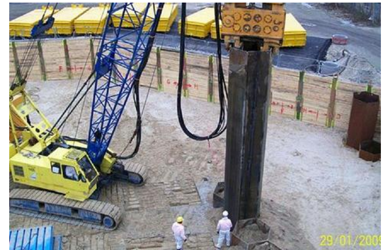
6. Bodenaushubmaßnahme mittels Wabenverfahren
