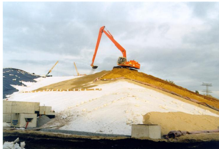
5. Abdichtung einer Betriebsdeponie/ Anlegen einer Grünfläche
