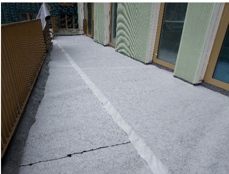
Schnelles Einpassen, Verlegen und Überlappen der Drainagematte FDV-1F.
