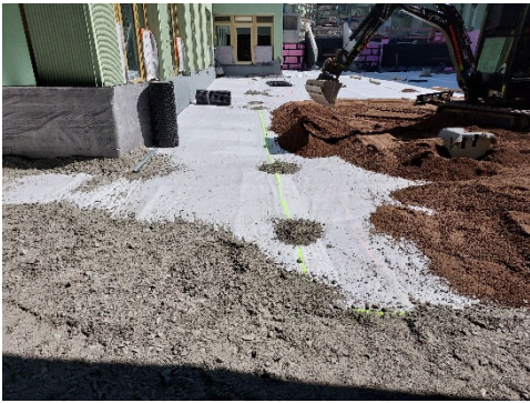
Verteilung von Substrat und Schotter im Vorkopfverfahren.
