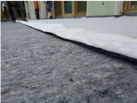
Nahaufnahme Schutzvliesstoff ESV 650 und Drainagematte FDV-1F.
