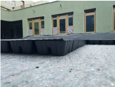
Schutzlage ESV 650 und Drain.-Wasserspeicherplatte FSDrain 60
