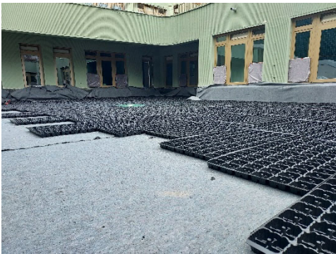
Hochführen der Schutzlage an den Wandanschlüssen
