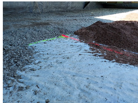
Linkes: Aufbau für die Terrasse mit Schotter. Rechts: Substrat für die intensive Begrünung.
